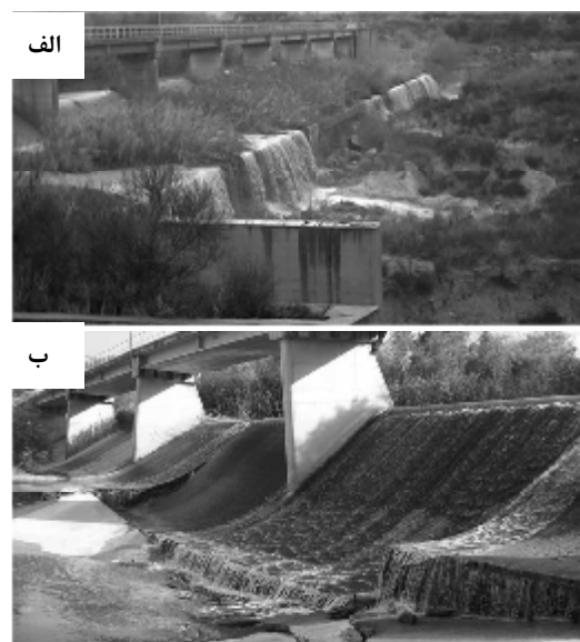
شکل ۱- آب‌شستگی در پایین‌دست سد انحرافی سایروکریک در رودخانه آگری در جنوب ایتالیا. الف) فوریه ۲۰۰۴ و ب) می ۲۰۰۹ (هوگر، ۱۹۹۲)
